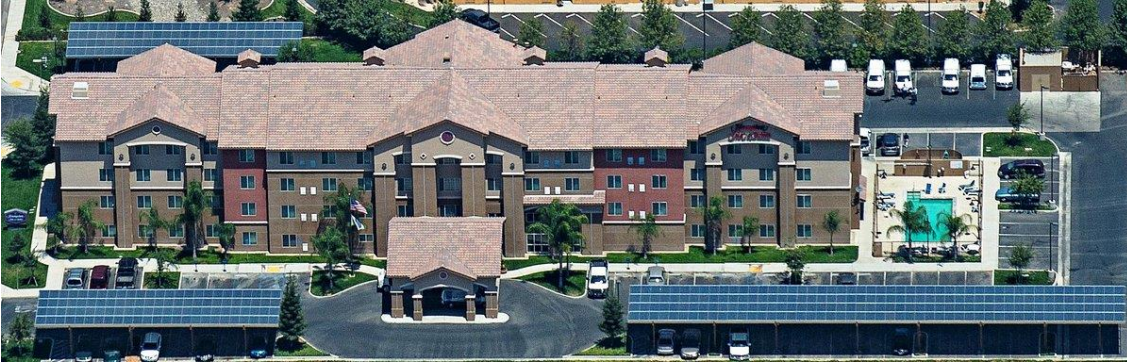
Şekil 6. Kaliforniya'da fotovoltaik kurulumlu Hotel Hampton Inn
