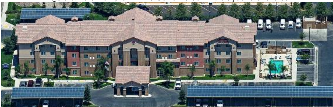
Figura 6. Hotel Hampton Inn na Califórnia com instalação fotovoltaica
