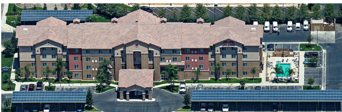
Figura 6. Hotel Hampton Inn in California con impianto fotovoltaico
